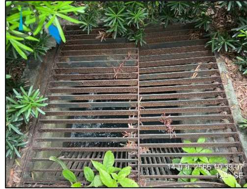
ภาพที่ 14 ตะแกรงดักขยะที่ Man Hole สุดท้าย
